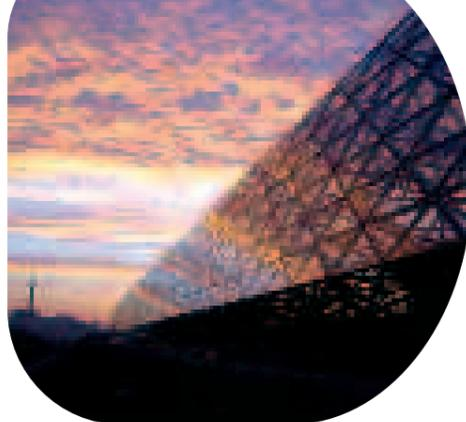
Sound Barrier состоит примерно из 150 сегментов. Основание треугольных стеклянных пластин – около 3 метров. Все 8320 пластин различаются по размеру, что значительно усложнило процесс логистики, как на стадии производства стекла, так и в ходе его монтажа.
