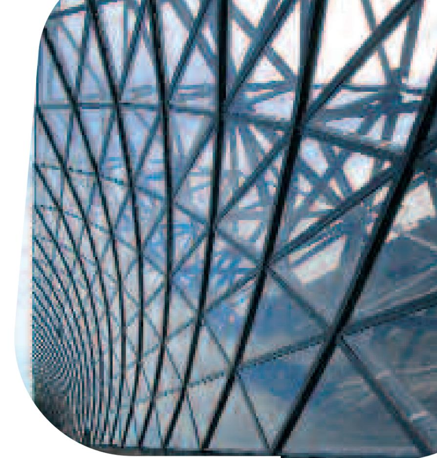
будут построены из стекла, смонтированного на металлоконструкции так, чтобы отпадала необходимость в монтажных замерах. Это означает создание элементов любой формы и размеров при более низких затратах.
