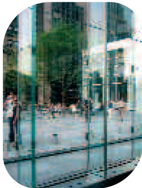
**Optiwhite™** размером приблизительно 1000 см в высоту и 48 см в длину. Сборка панелей осуществлялась с помощью специальной технологии, разработанной и запатентованной компанией Bischoff Glastechnik (BGT), которая специализируется на обработке стекла. В качестве опоры панелей крыши были использованы 10 горизонтальных стеклянных балок с 24 вертикальными опорными стенками, соединяющими стеклянные панели фасада.
